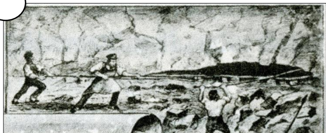
UVOLŇOVÁNÍ OPĚRNÝCH PILÍŘŮ
